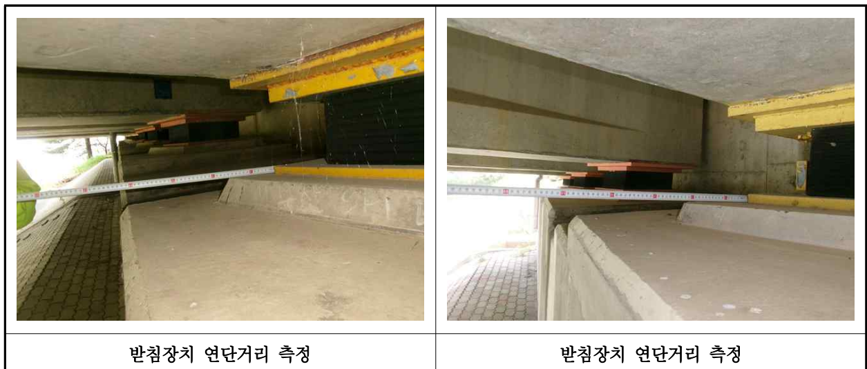
【사진 7.3.15】 교량받침장치 연단거리측정
