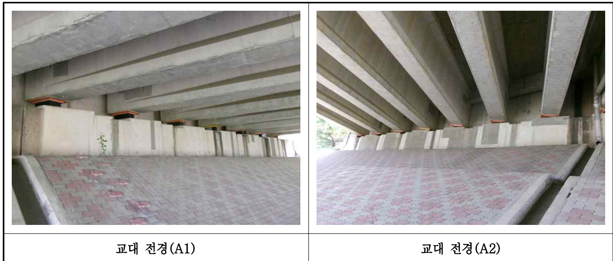
【사진 7.3.8】 교대 전경
