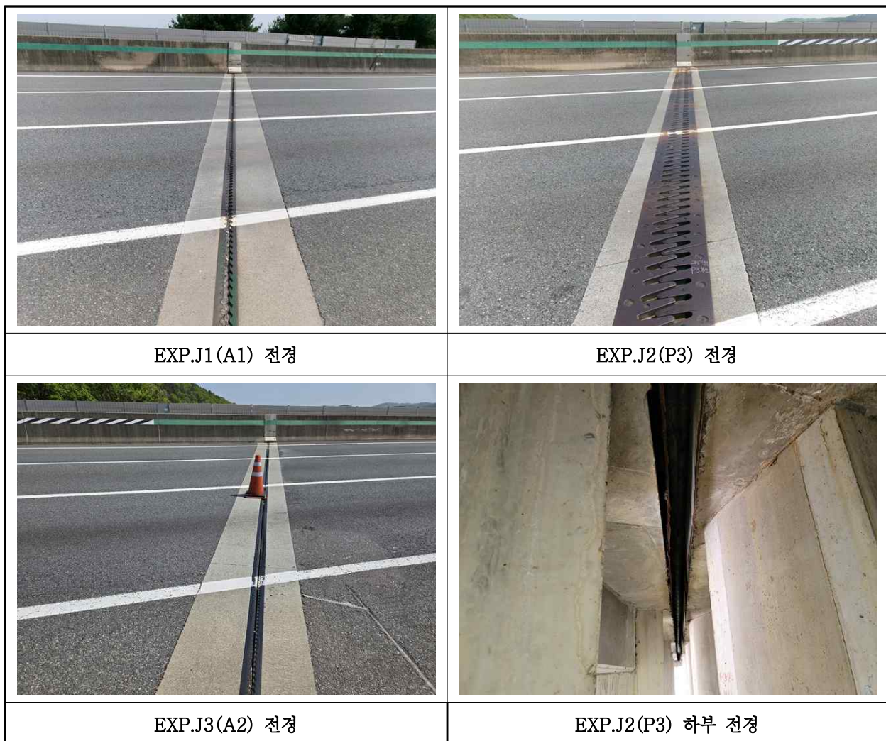
【사진 7.3.17】 신축이음장치 전경
