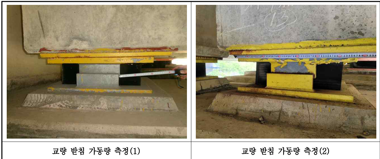
【사진 7.3.16】 교량받침 이동량 측정
