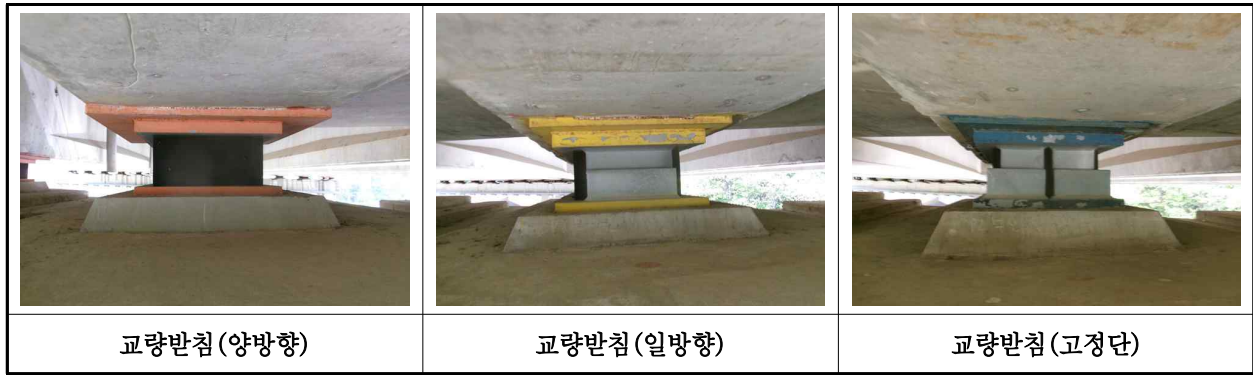
【사진 7.3.13】 교량받침 전경
