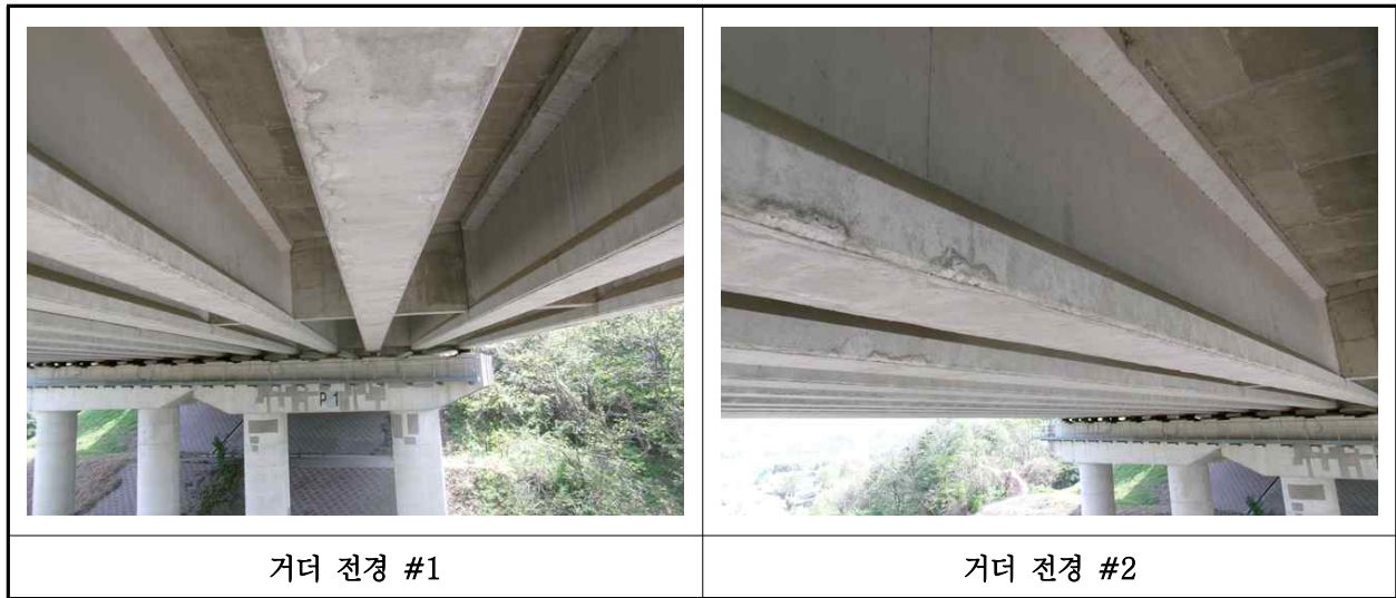
【사진 7.3.4】 거더 전경
