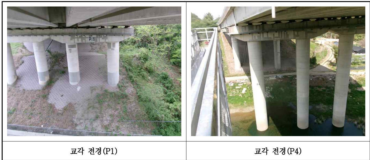
【사진 7.3.10】 교각 전경
