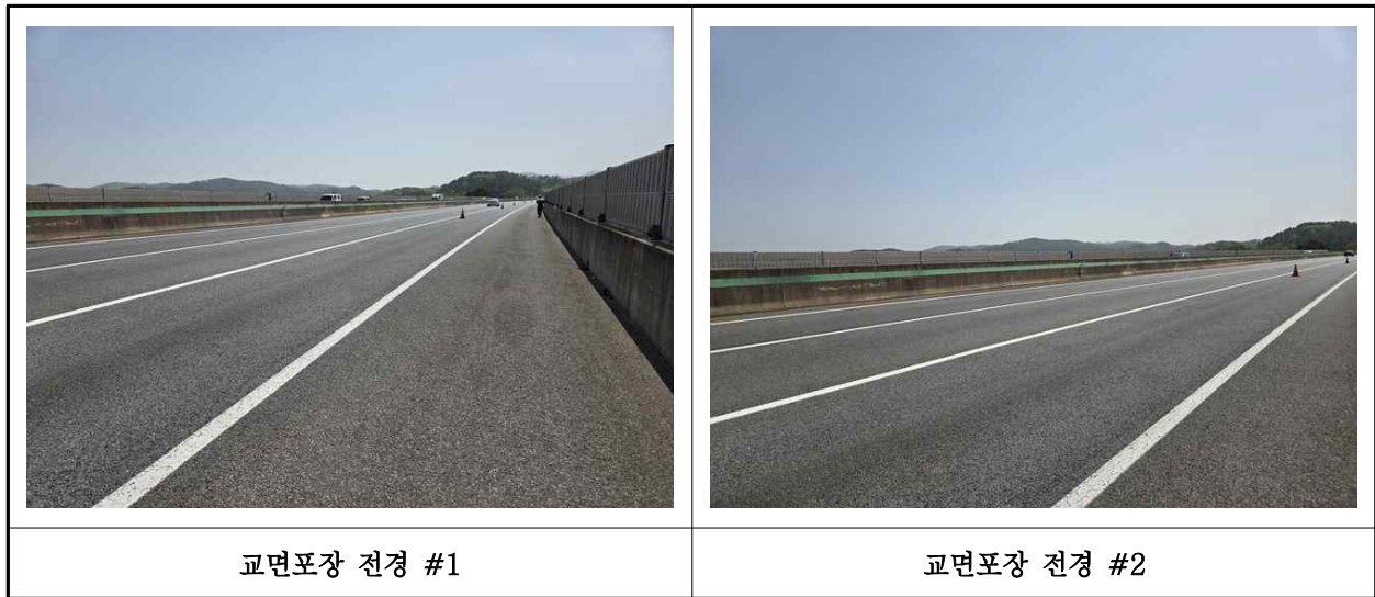
【사진 7.3.20】 교면포장 전경
