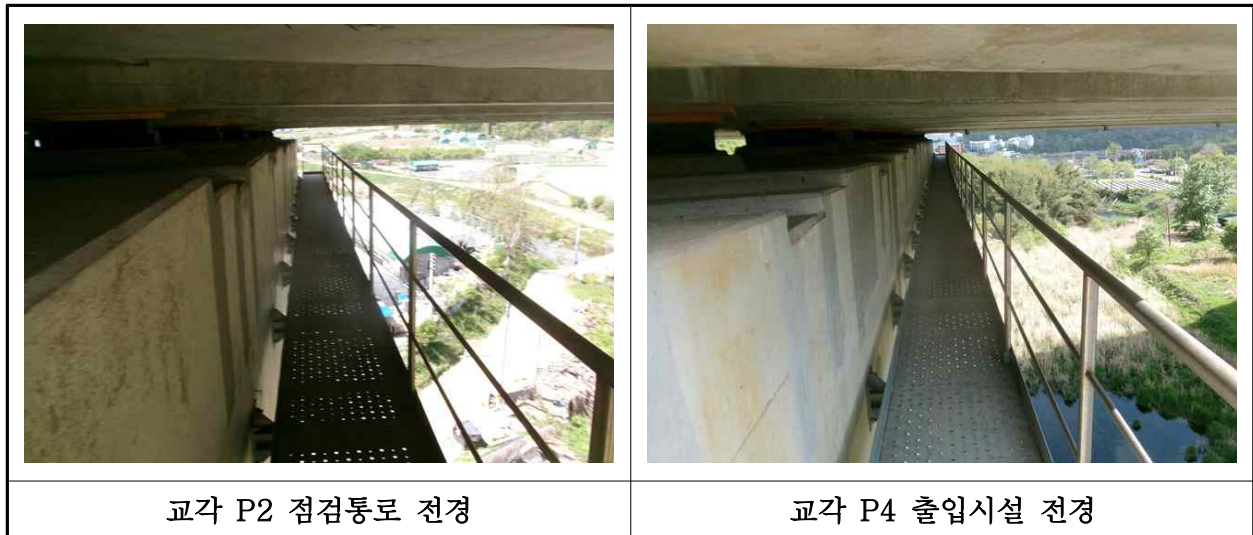
【사진 7.3.26】 교량 점검시설 전경
