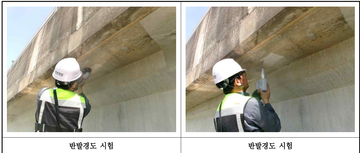
【사진 7.4.2】 반발경도시험 현장사진
