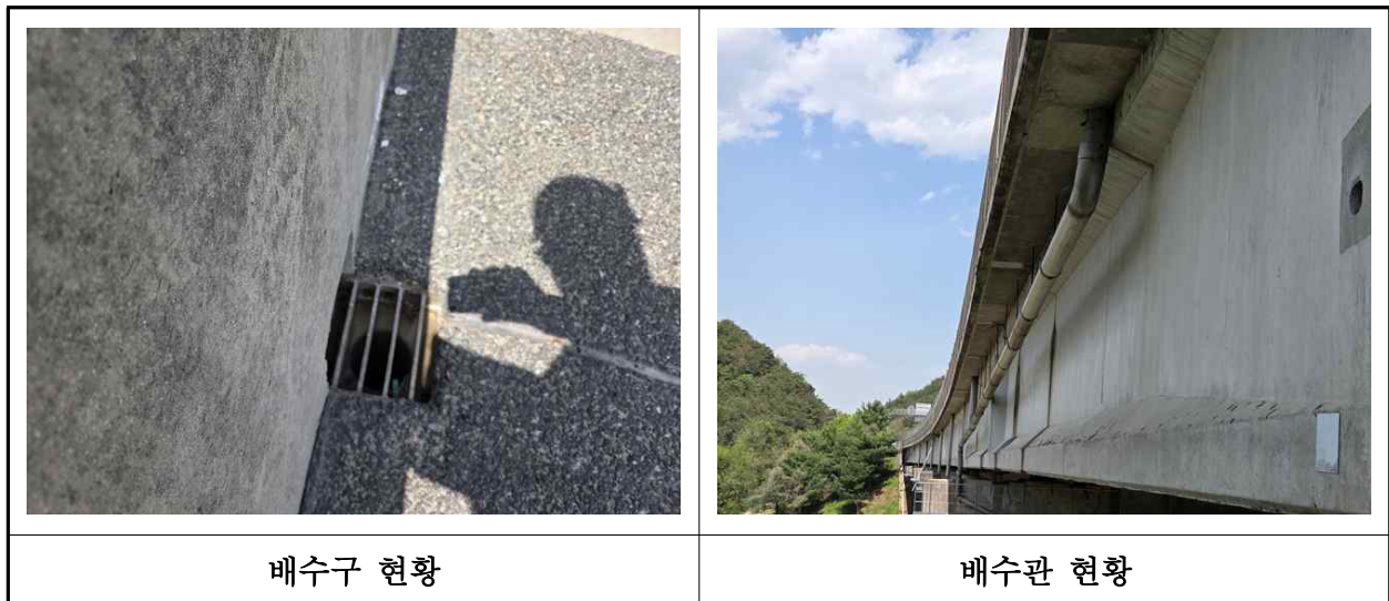
【사진 7.3.22】 배수시설 전경
