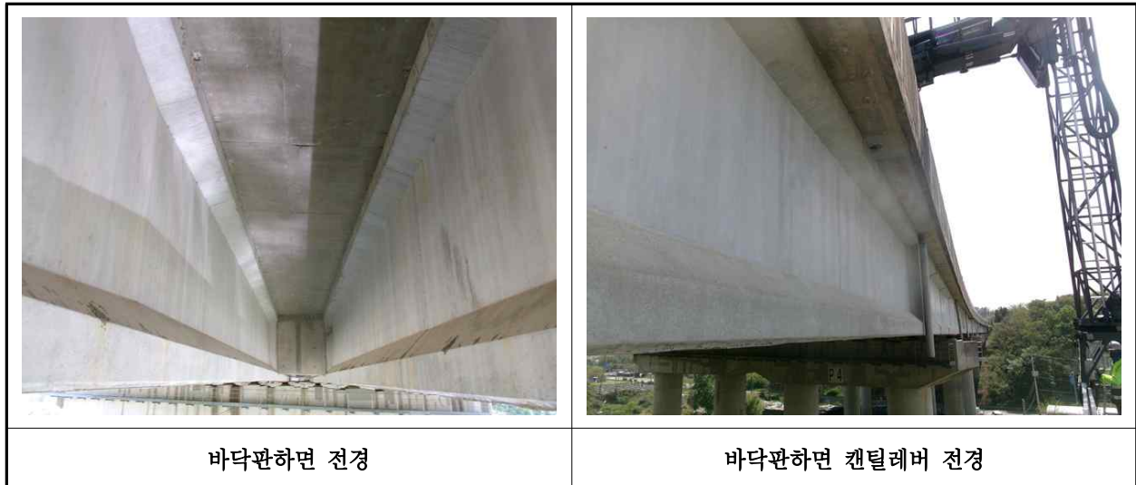
【사진 7.3.2】 바닥판하면 전경
