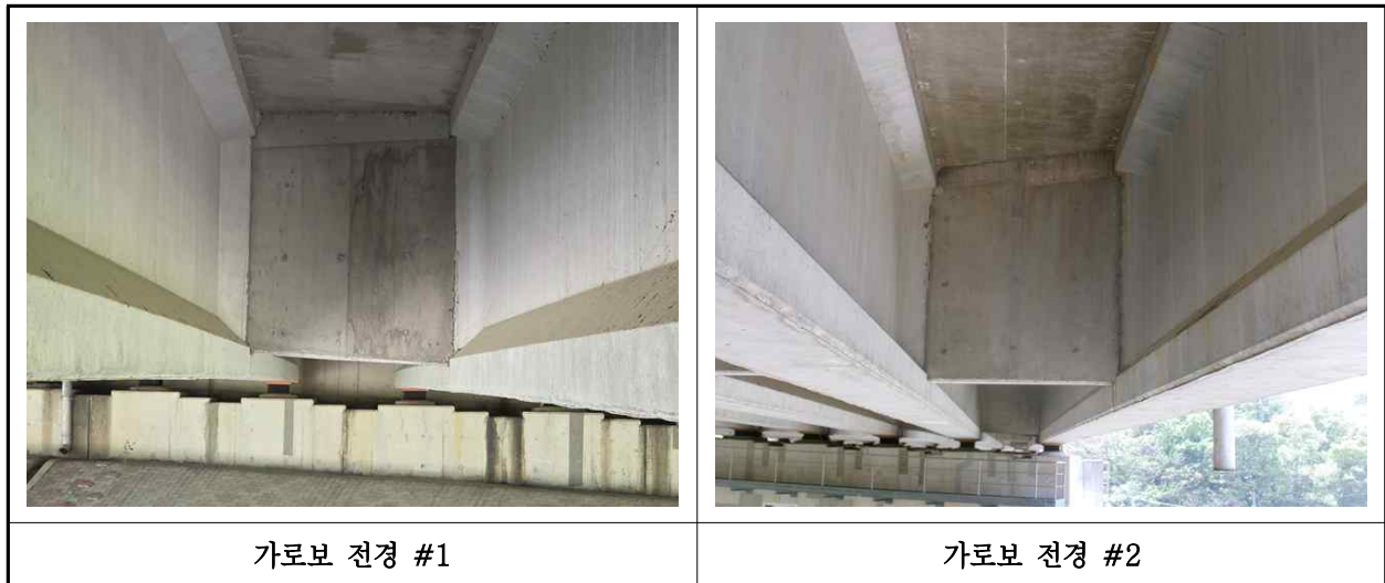
【사진 7.3.6】 가로보 전경
